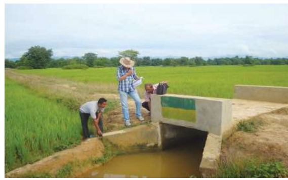
फोटो : Slab Culvert
