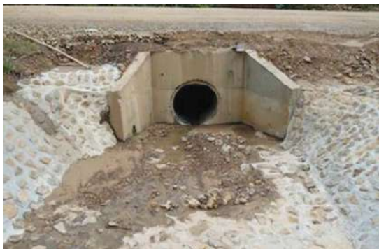
फोटो : Pipe Culvert
